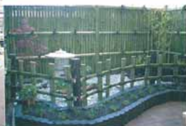
シアタールームオープンにあわせて、バルコニーを坪庭にリノベーション
