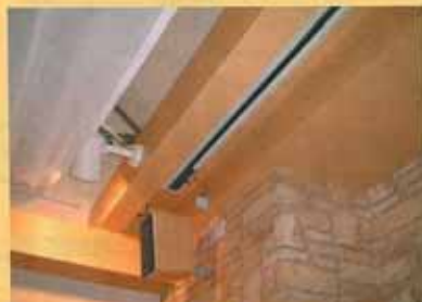
プロジェクターが天井に吊りされている箇所は軽量鉄骨。部屋のサイドから梁のように渡し、雰囲気にもマッチする壁紙を貼って仕上げた。天井は吸音とやわらかなライティングを得るために布を効果的に使っている(左)。スクリーン用にボックスを設け、スクリーンボックスごとかくしてある
