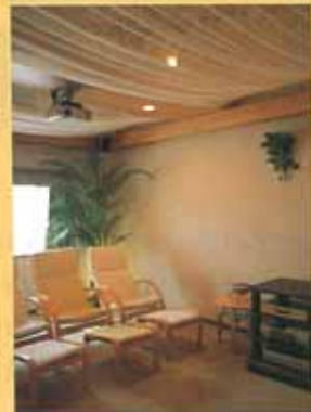
プロジェクターが天井に吊りされている箇所は軽量鉄骨。部屋のサイドから梁のように渡し、雰囲気にもマッチする壁紙を貼って仕上げた。天井は吸音とやわらかなライティングを得るために布を効果的に使っている(左)。スクリーン用にボックスを設け、スクリーンボックスごとかくしてある
